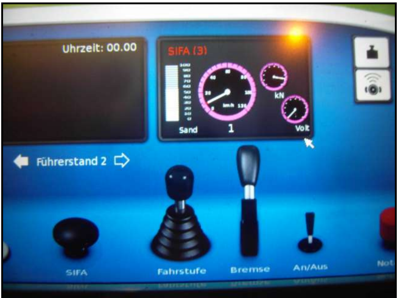
Foto n. 5: il pulsante SiFa era posizionato sulla sinistra.
